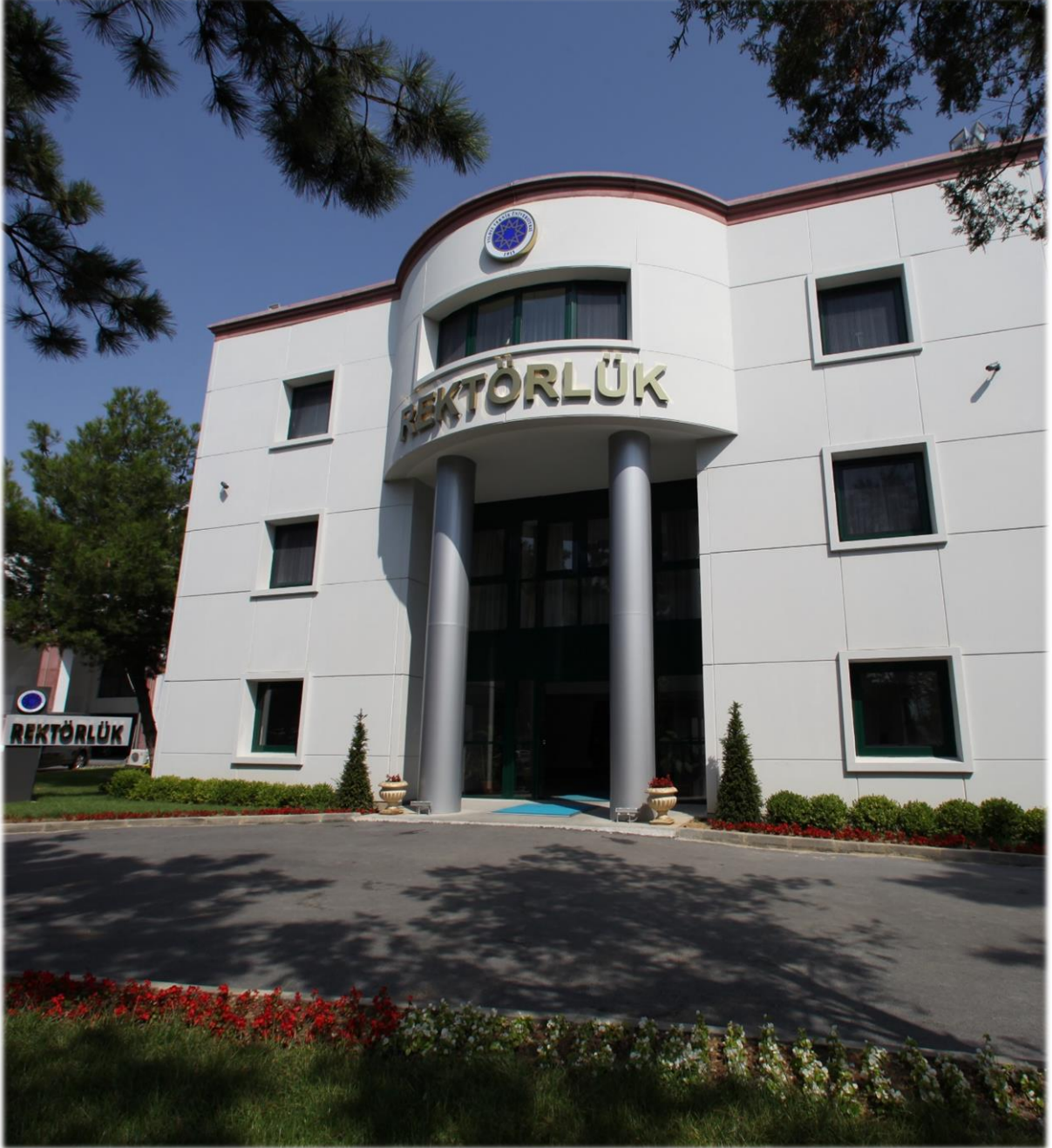
Rektörlük Binası, Davutpaşa Yerleşkesi
